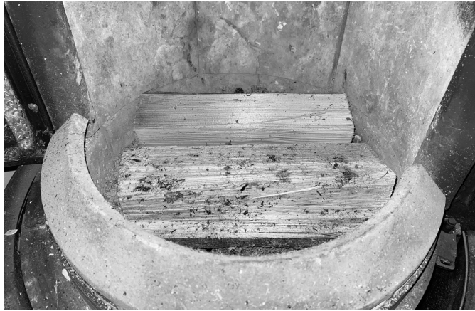
Abb. 4.2.2 Holzaufgabeart bei Nennwärmeleistung
